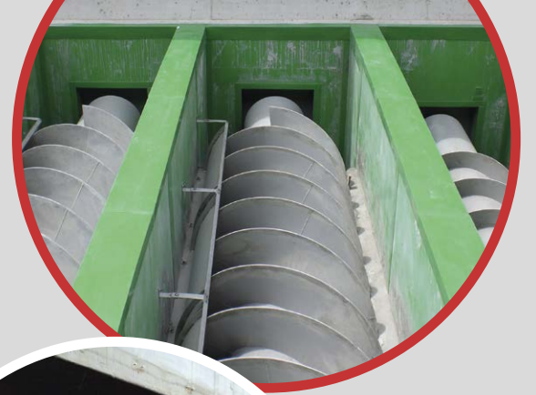
BKU II HDPE T-grip aangebracht in vijzelgoot
