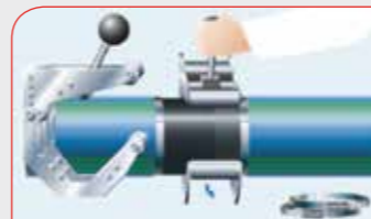
Afb. 34: De oxidelaag met een geschikt schilapparaat verwijderen
