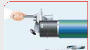
Afb. 8: De oxidelaag met een schilapparaat verwijderen
