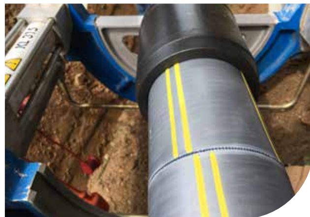
Voorbeeld van combinatie las (spiegel/elektrolas)
