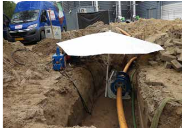
AA & Maas en Bosch, biogasleiding opwerkingsinstallatie, 16 bar
