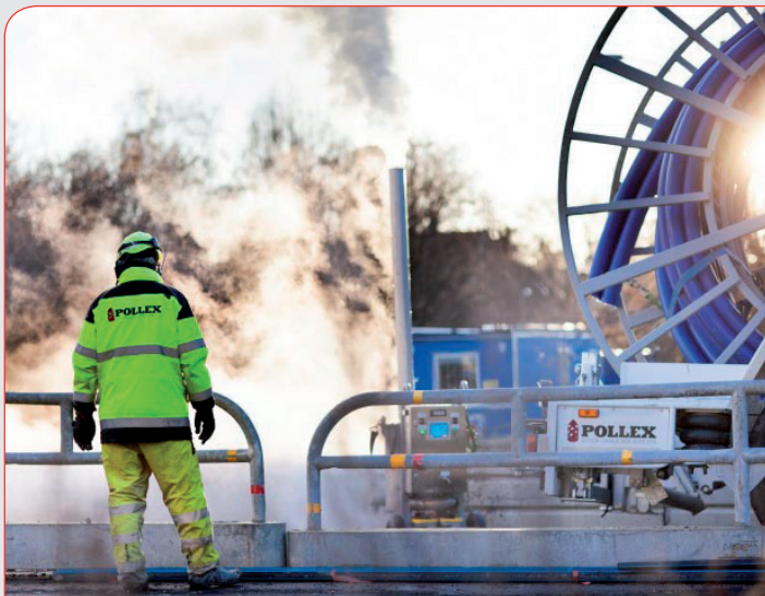
Diameter van een egeliner® herstellen door middel van stoom
