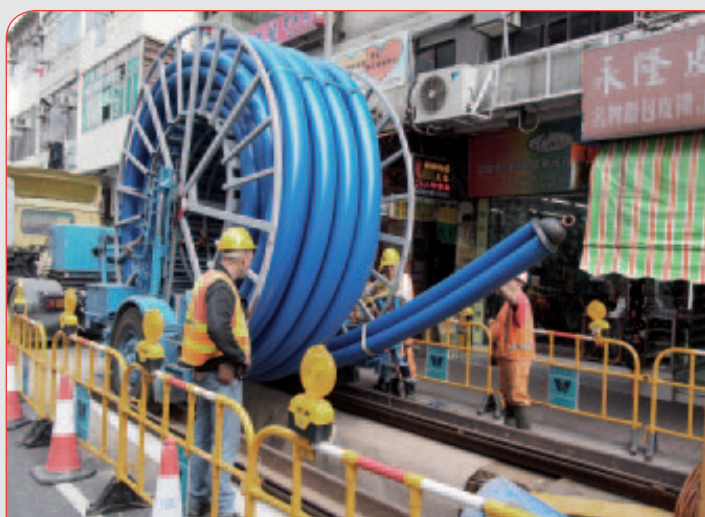
Toepassing van egeliner ® op een locatie waar de ruimte beperkt is in Hong Kong.
