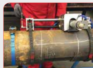
Stap 8. Horizontale zaagsnede
